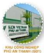
KHU CÔNG NGHIỆP PHU AN THANH (G01)
